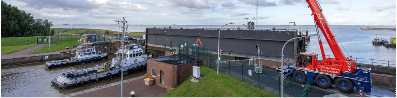
Eines der größten Projekte in Emden: die Modernisierung der Großen Seeschleuse
